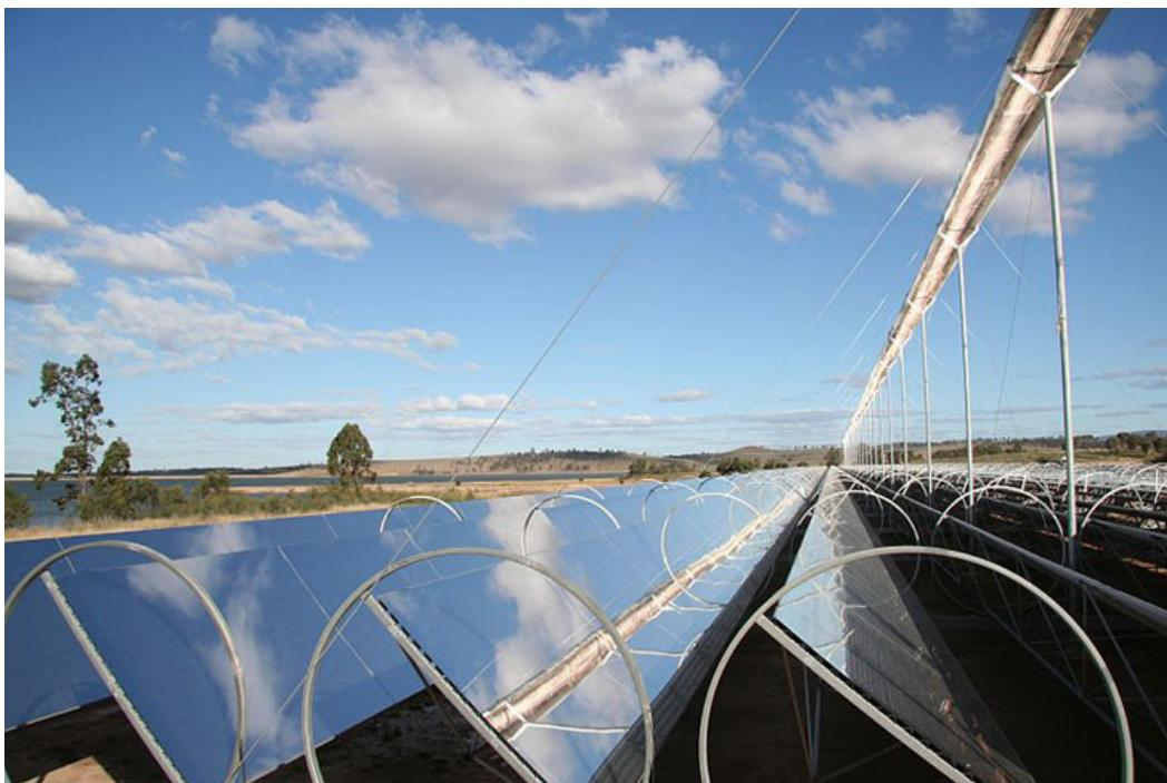
**Εικόνα 3.3. Σύστημα Linear Fresnel Reflector**
