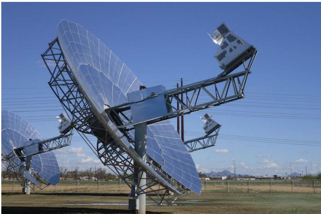
**Εικόνα 3.4. Solar Power Stirling Engine**
