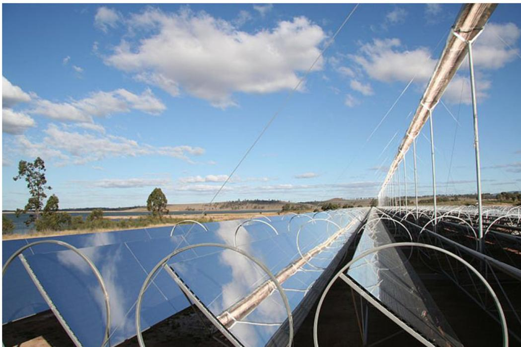
**Εικόνα 3.3. Σύστημα Linear Fresnel Reflector**
