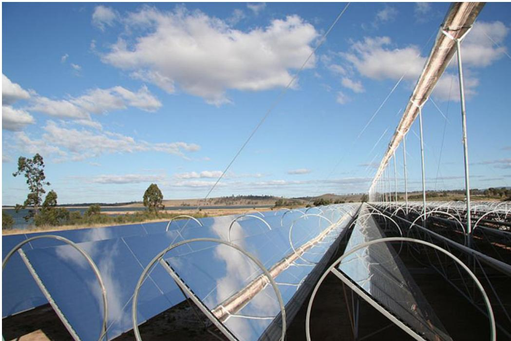
**Εικόνα 3.3. Σύστημα Linear Fresnel Reflector**
